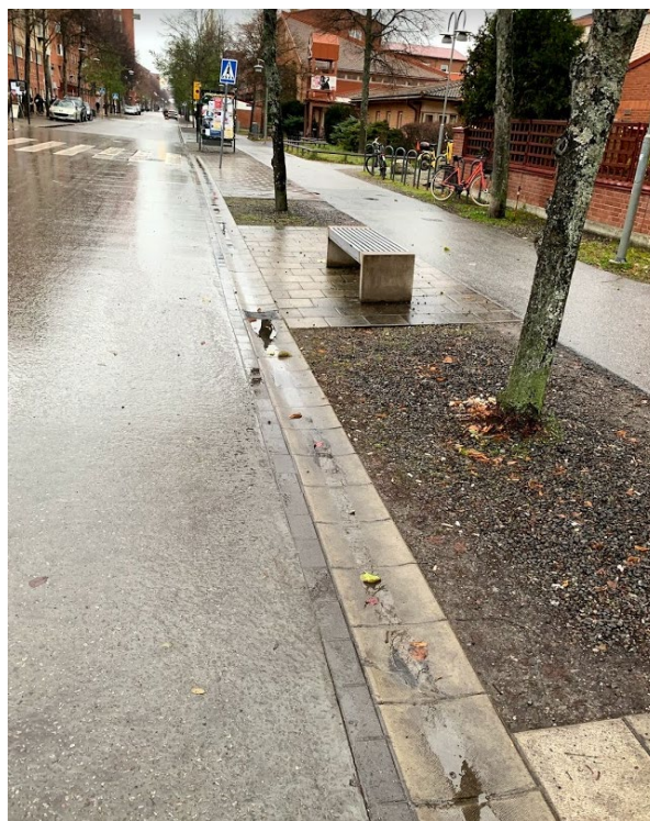
Figur 3. Befintliga växtbäddar för träd längs med Skarpnäcks allé för avrinning från väg- och gångbana. Foto Åsa Andersson 2019-11-12.
